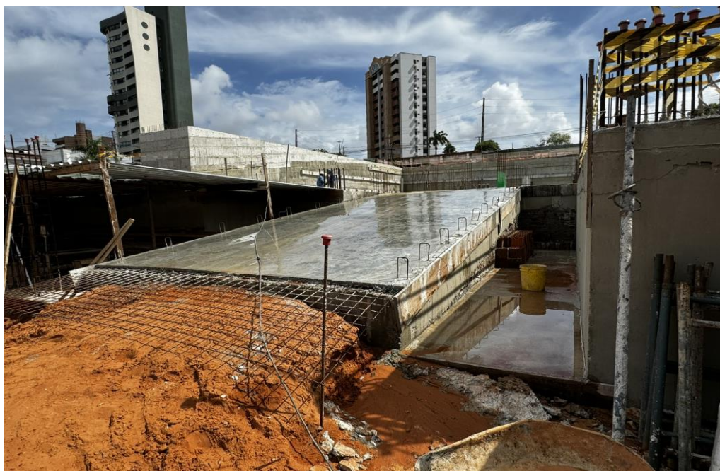
Figura 9. Laje de piso do segundo subsolo, rampa de entrada do prédio concretada parcialmente.
