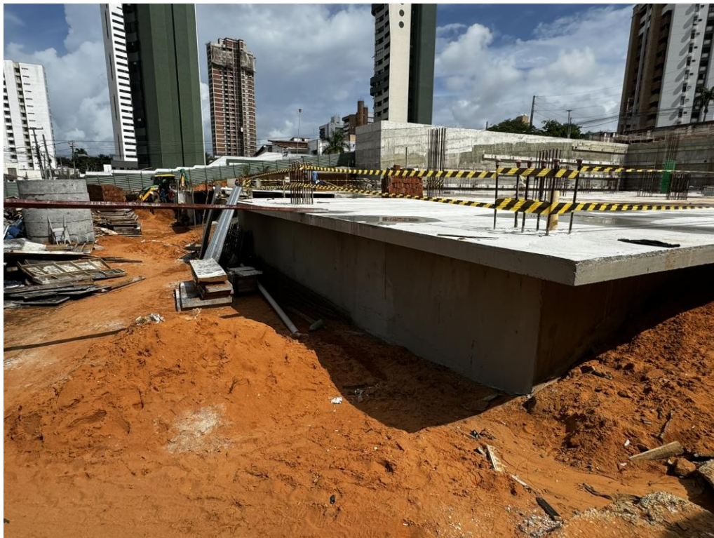
Figura 8. Laje de piso do segundo subsolo com balanço.
