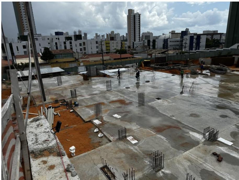
Figura 12. Visão geral da laje do subsolo 2 após concretagem, com as tampas dos poços de infiltração de acordo com o projeto de águas pluviais.
