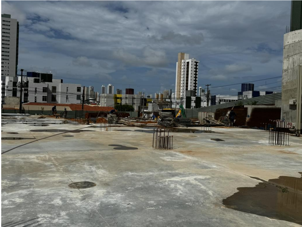
Figura 7. Laje de piso do segundo subsolo .
