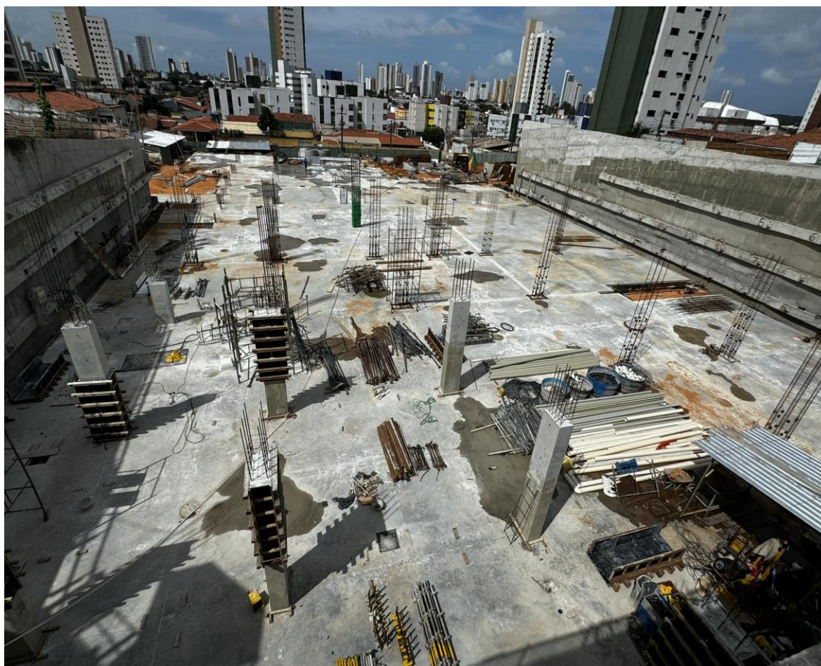
Figura 1. Visão geral da obra.
