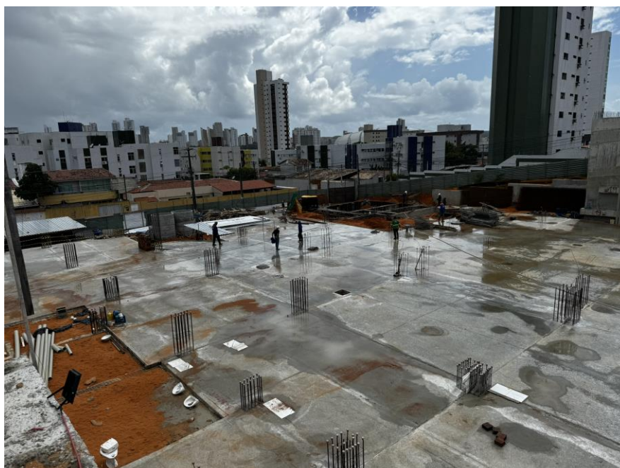
Figura 6. Concretagem da laje de piso do segundo subsolo.
