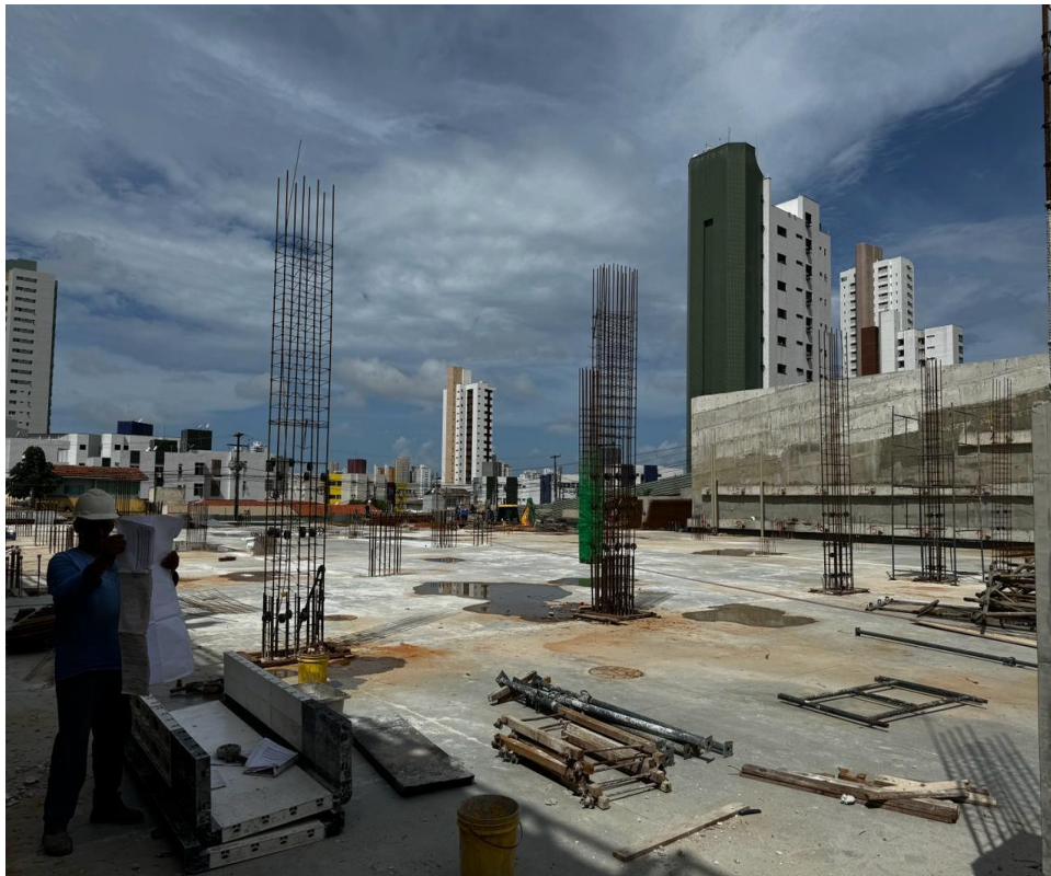
Figura 11. Retirada das formas dos Pilares concretados no subsolo 2..
