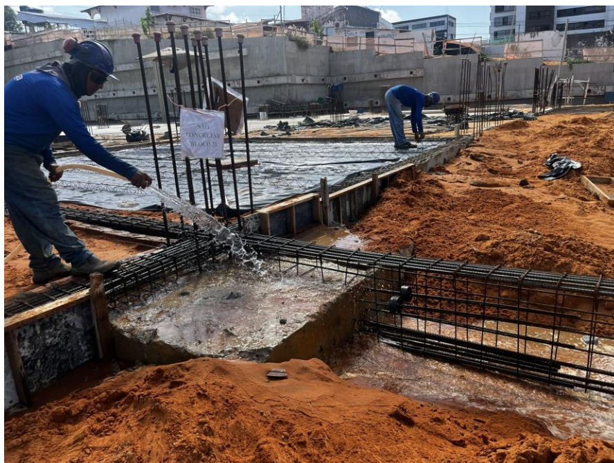
Figura 5. Montagem e concretagem das vigas baldrame que chegam ao bloco 73.
