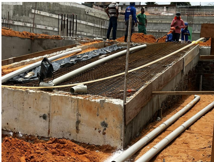
Figura 4. Montagem e concretagem da rampa de entrada do sub solo 2.
